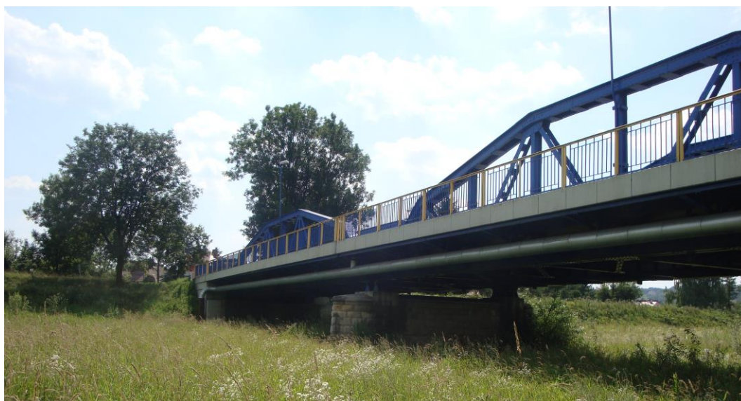
Rys. 68. Most w Tuchowie na ul. Daszyńskiego, Droga Krajowa 977
